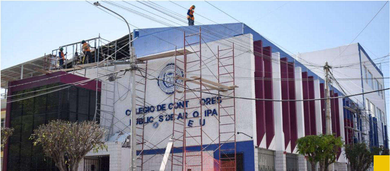
Trabajos de remodelación del color de la pintura de la fachada de nuestro local institucional
