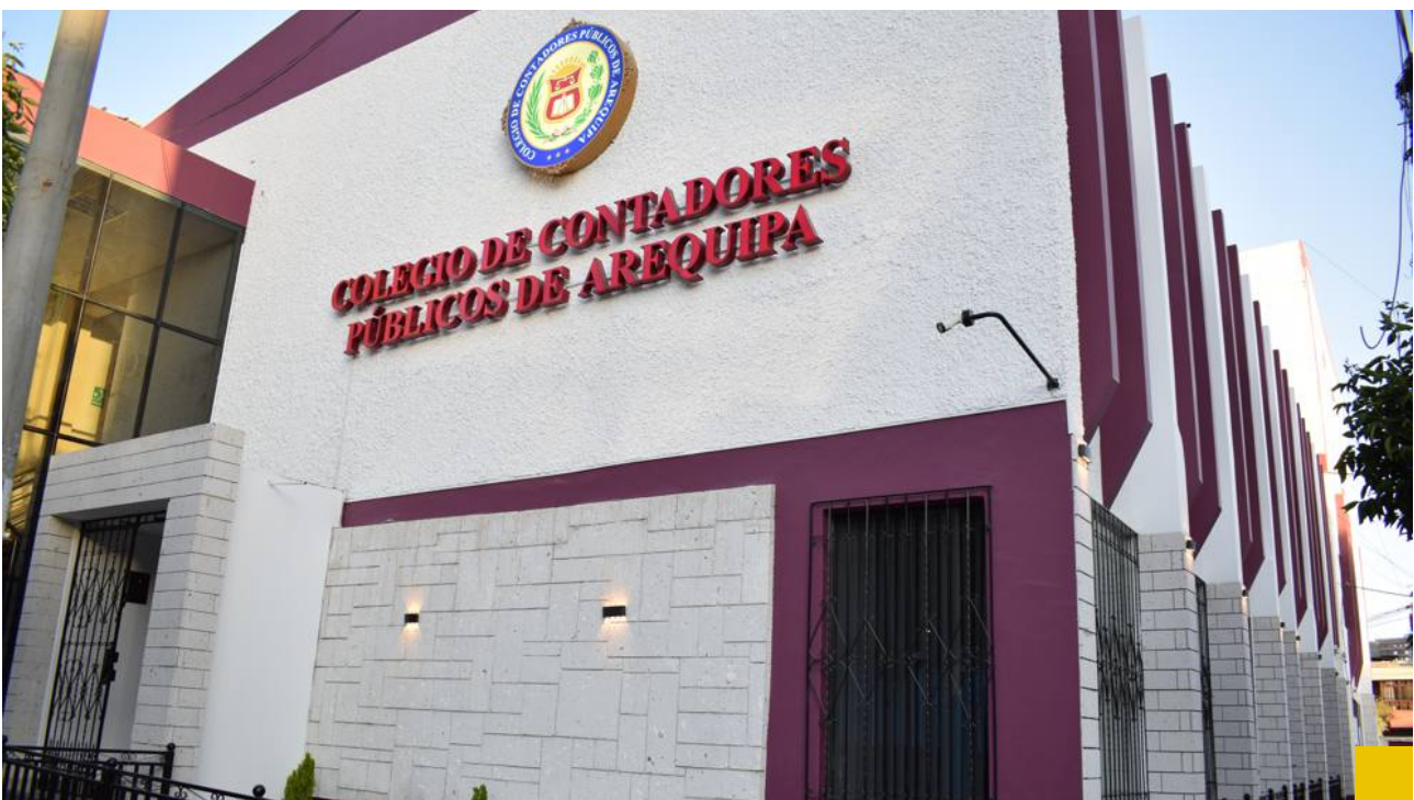
Fachada renovada y mejorada.
