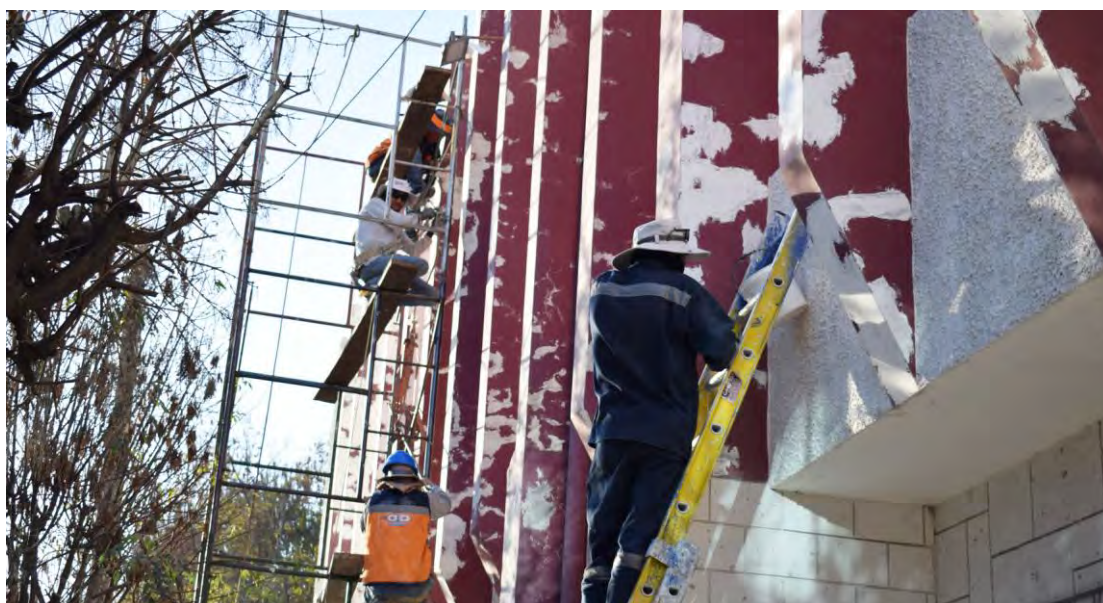
En julio 2023 se realizó trabajos de mantenimiento y remozado de la fachada de nuestro local institucional
