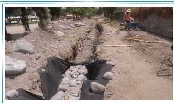
Cerrando con geotextil tramo intermedio de dren.
