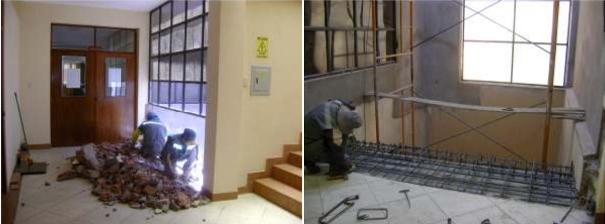
*Trabajos de preparación de ambientes del 1er. al 4to. piso para la instalación del nuevo ascensor.*
